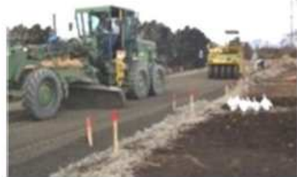
丁張りによる施工
